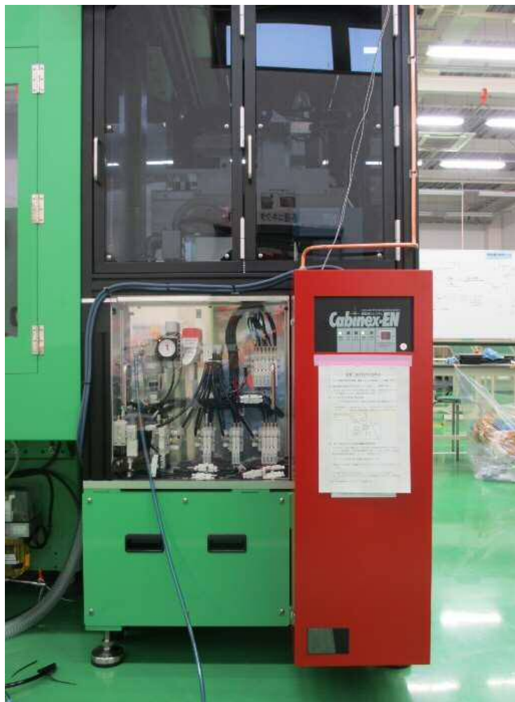
⑪自動消火装置
